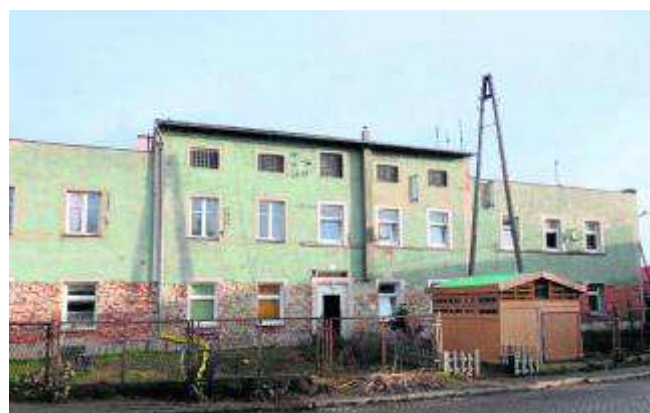
W tym budynku doszło do zadymienia
